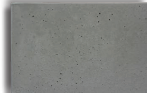
Béton couleur naturelle
